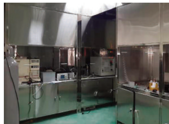
Hệ thống thiết bị thử nghiệm Hơi khí độc
