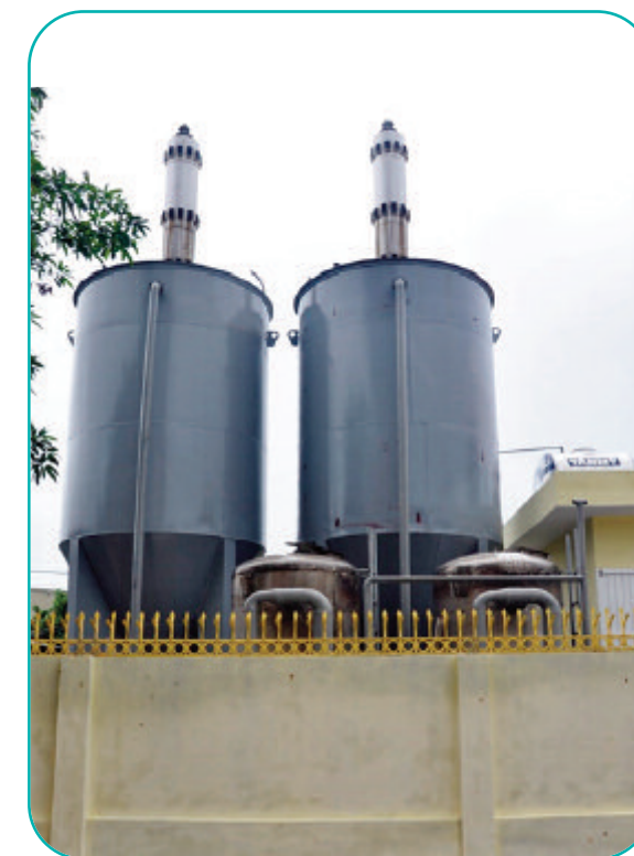
Tên dự án: Hệ thống xử lý nước ngầm, công suất 500 m 3 /ngày Địa chỉ: Lai Xá, Hoài Đức, Hà Nội Công việc: Gia công lắp đặt hệ thống xử lý nước
