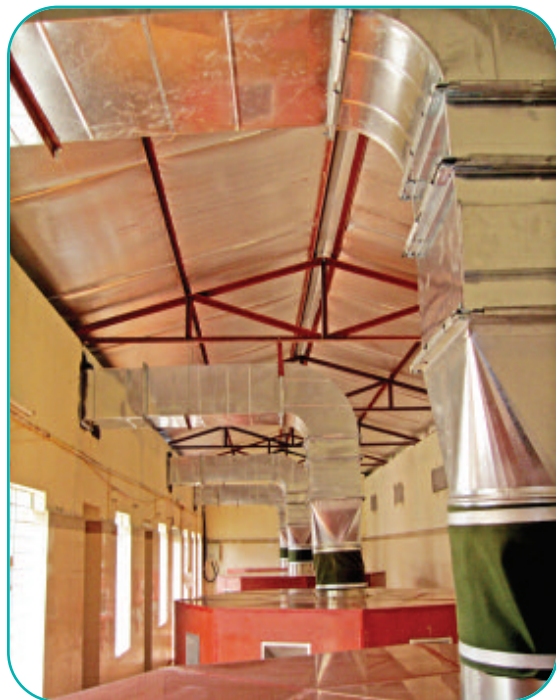
Dự án: Công ty Nhựa Vinh Hạnh – Nhà máy tại Kim Bôi, Hòa Bình và Hà Đông, Hà Nội Công việc: Hệ thống xử lý bụi và dung môi sơn Thiết bị chính: Ventury vận tốc thấp - Công suất: 22.000m 3 /h; Màn nước - Công suất: 12.000m 3 /h.
