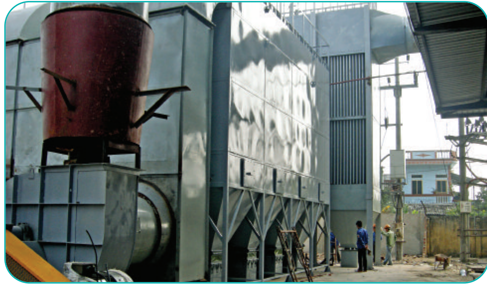
Dự án: Nhà máy luyện thép Hưng Thịnh Địa chỉ: KCN Đồng Văn, Hà Nam Công việc: Hệ thống xử lý khói lò Thiết bị chính: Lọc bụi túi vải rung rũ khí nén; Công suất: 110.000m 3 /h
