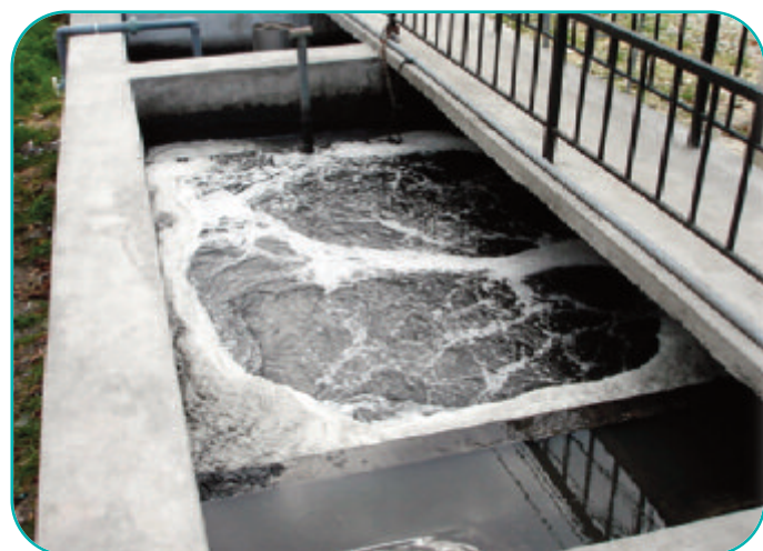
Tên dự án: Trường đào tạo nghề điện Địa chỉ: xã Tân Dân, huyện Sóc Sơn, Hà Nội Công việc: Trạm xử lý nước thải sinh hoạt
