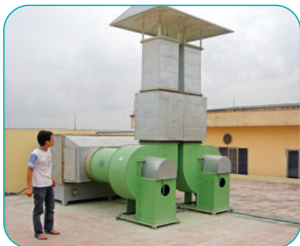
Dự án: Công ty Nhựa Vinh Hạnh – Nhà máy tại Kim Bôi, Hòa Bình và Hà Đông, Hà Nội Công việc: Hệ thống xử lý bụi và dung môi sơn Thiết bị chính: Ventury vận tốc thấp - Công suất: 22.000m 3 /h; Màn nước - Công suất: 12.000m 3 /h.
