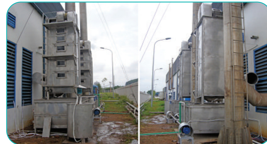
Dự án: Công ty Sữa Vinamilk Bắc Ninh Địa chỉ: KCN Tiên Sơn, Bắc Ninh Công việc: Hệ thống xử lý khói thải lò hơi đốt dầu DO Thiết bị chính: Tháp hấp thụ tầng sô; Công suất: 16.000m 3 /h
