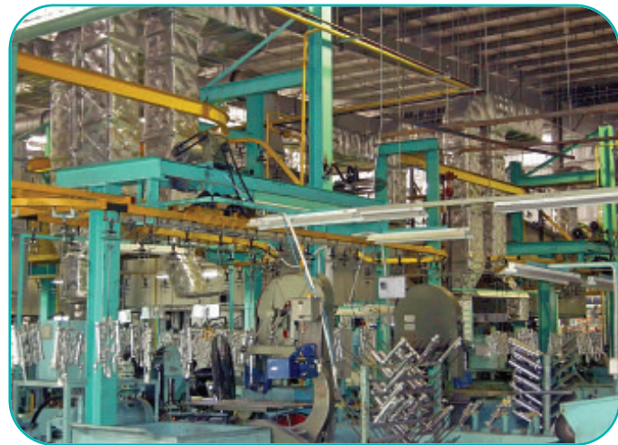
Dự án: Công ty MACHINO Địa chỉ: KCN Thăng Long - Hà Nội Công việc: Hệ thống điều hòa sử dụng tấm trao đổi nhiệt colling pad
