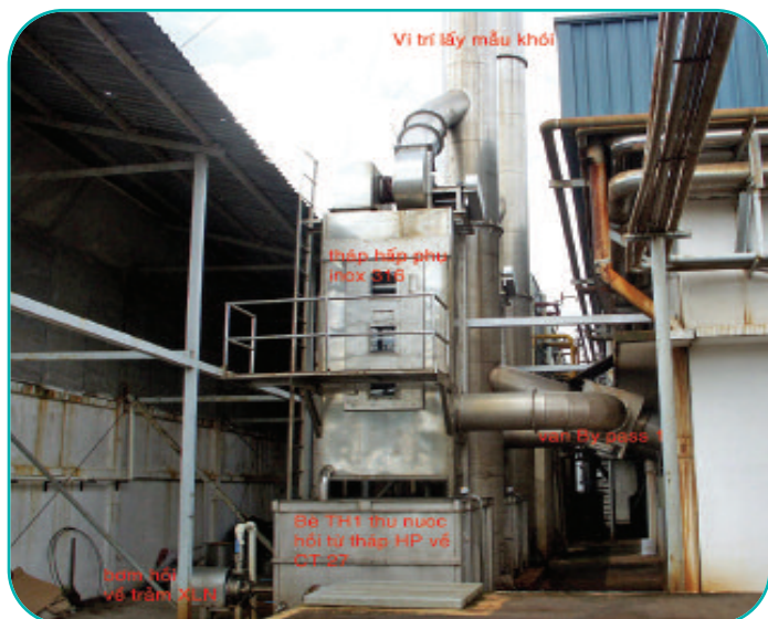
Dự án: Công ty Nhựa Vinh Hạnh – Nhà máy tại Kim Bôi, Hòa Bình và Hà Đông, Hà Nội Công việc: Hệ thống xử lý bụi và dung môi sơn Thiết bị chính: Ventury vận tốc thấp - Công suất: 22.000m 3 /h; Màn nước - Công suất: 12.000m 3 /h.
