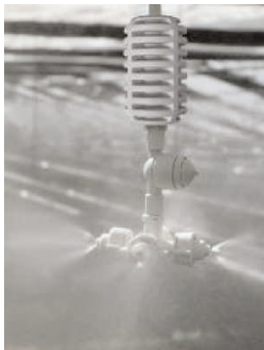
Hình 1: Hệ thống phun sương
