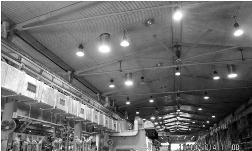
**Hình ảnh hiệu quả của hệ thống chiếu sáng tự nhiên phân xưởng điện – điện tử bằng ống dẫn sáng Solatube**
