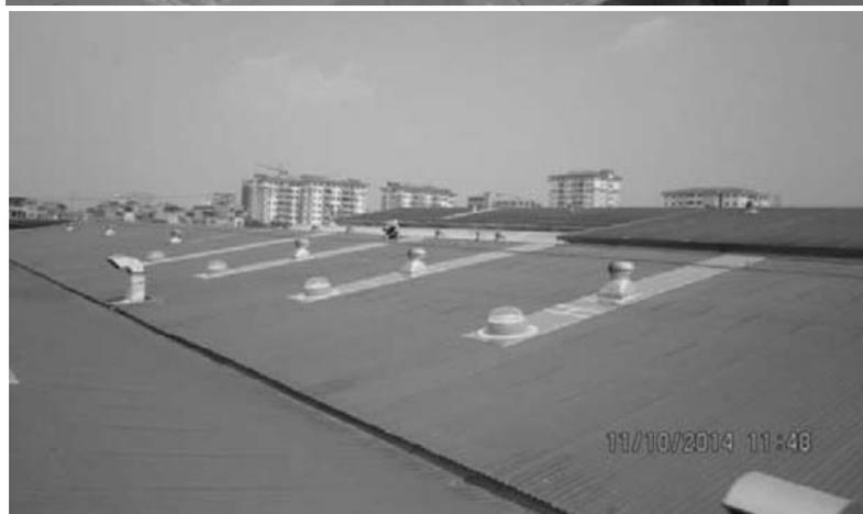
**Hình ảnh lắp đặt hệ thống chiếu sáng tự nhiên bằng ống dẫn sáng cho xưởng sản xuất điện – điện tử**
