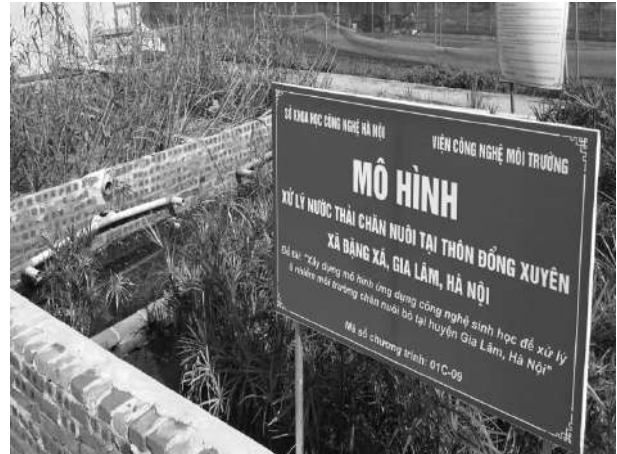
Hình 2. Mô hình xử lý nước thải tại làng nghề chăn nuôi bò sữa phân tán quy mô 10-12m 3 /ngày
