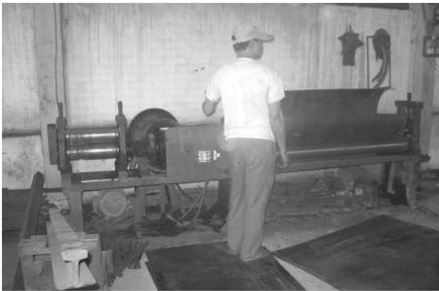
Hình 1. Công việc cuốn lô
