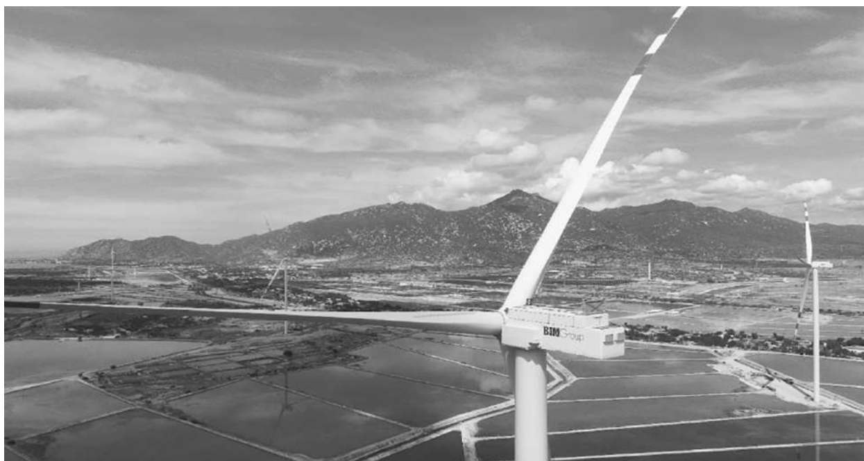
Hình 1. Dự án Điện gió BIM Ninh Thuận
