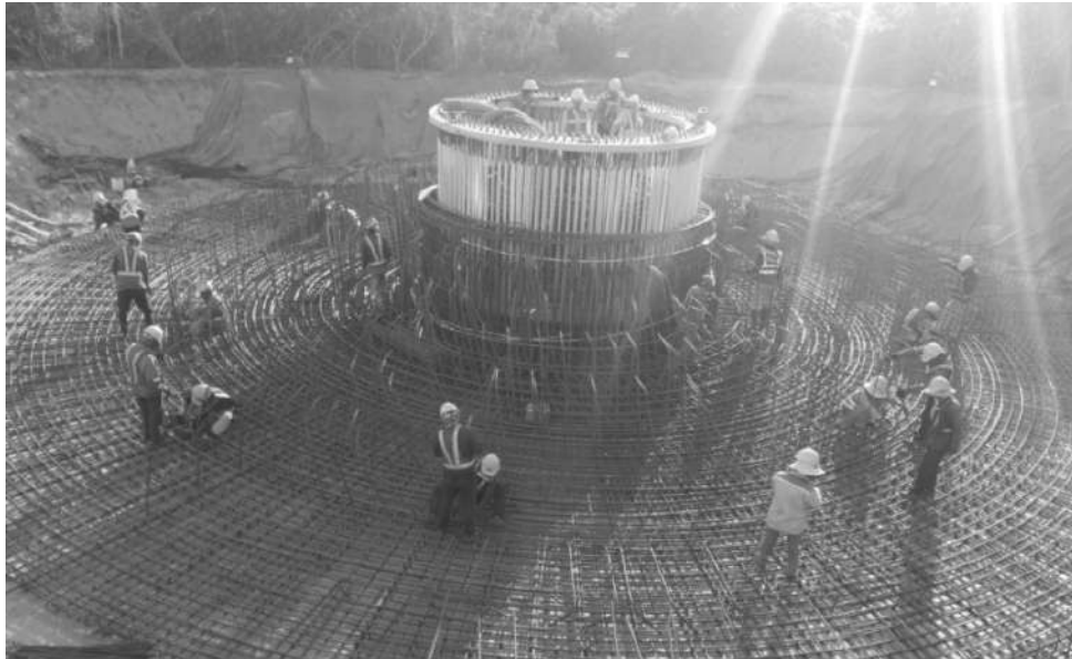
Hình 2. Lắp đặt cốt thép, cốp pha móng tuabin
