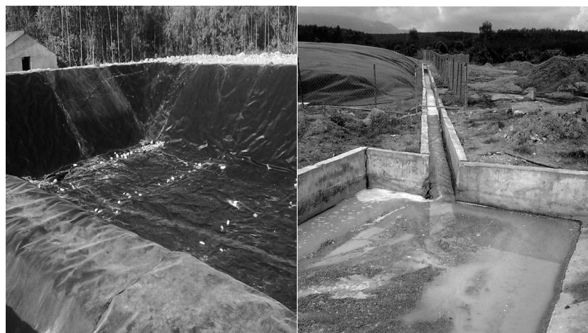
Hình 1: Thi công lắp đặt hệ thống xử lý nước thải
