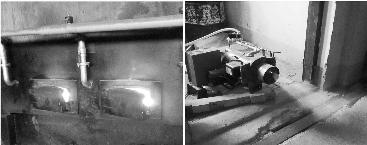
Hình 3: Sử dụng khí CH 4 thay than B4 và dầu DO đốt lò hơi
