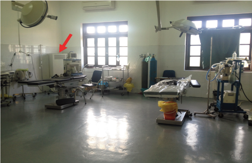
Hình 2. Thiết bị LSKK 500 m 3 /h đặt trong phòng mổ bệnh viện Đa khoa Phố Nối
